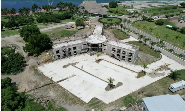
Construcción de Edificio Administrativo de la ASIPONA, Avance: 75%
