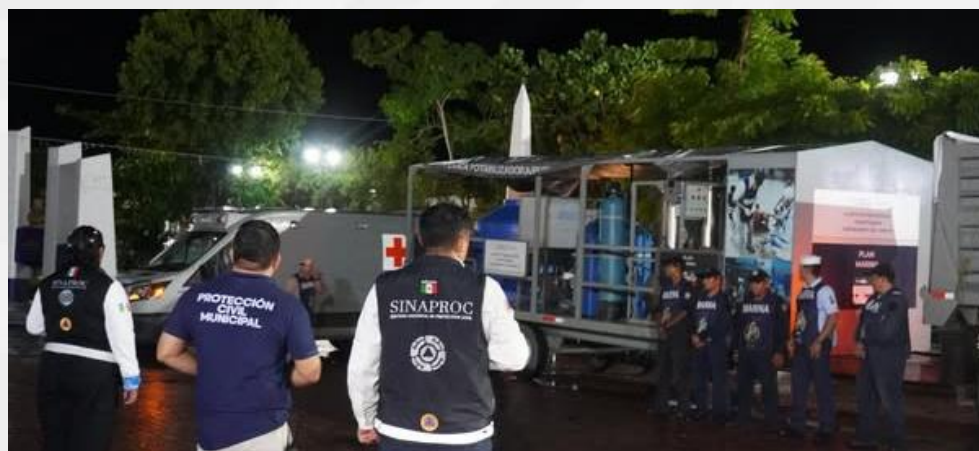
Instalación de planta potabilizadora.
