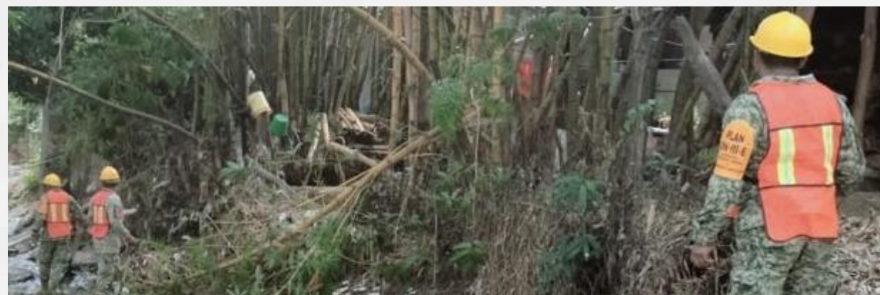
Trabajos de desazolve en cause de río en Pinotepa Nacional, por elementos de DEFENSA.
